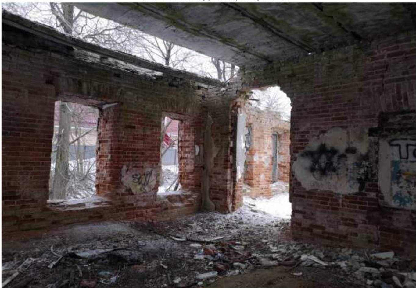
Фото 6. Помещение 1-го этажа западной пристройки в осях 1-2/А-Б.
