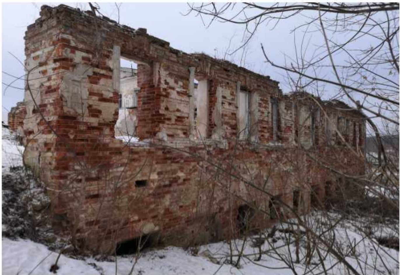
Фото 7. Фасад западной пристройки.
