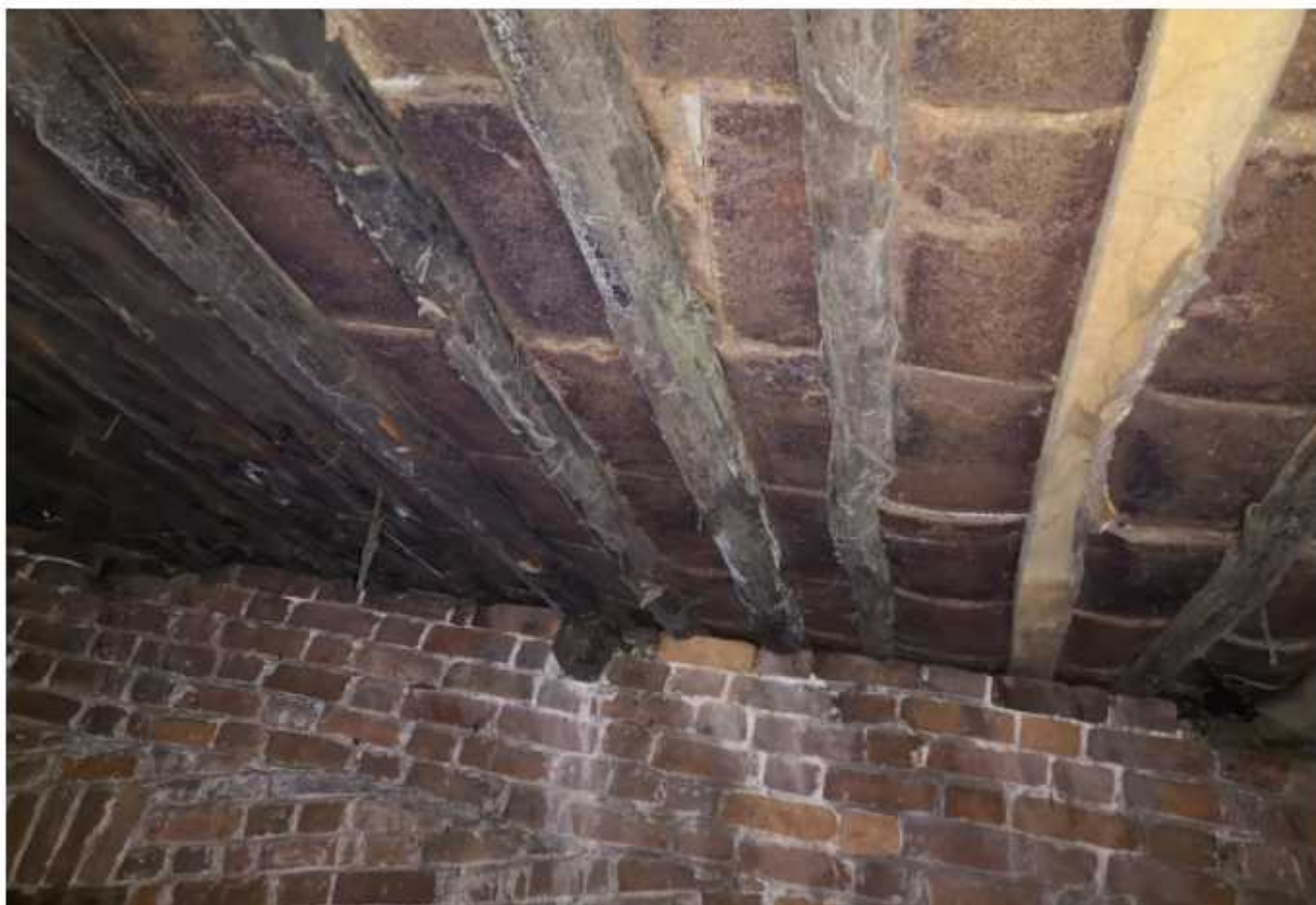
Фото 28. Обрешетка кровли основного здания.
