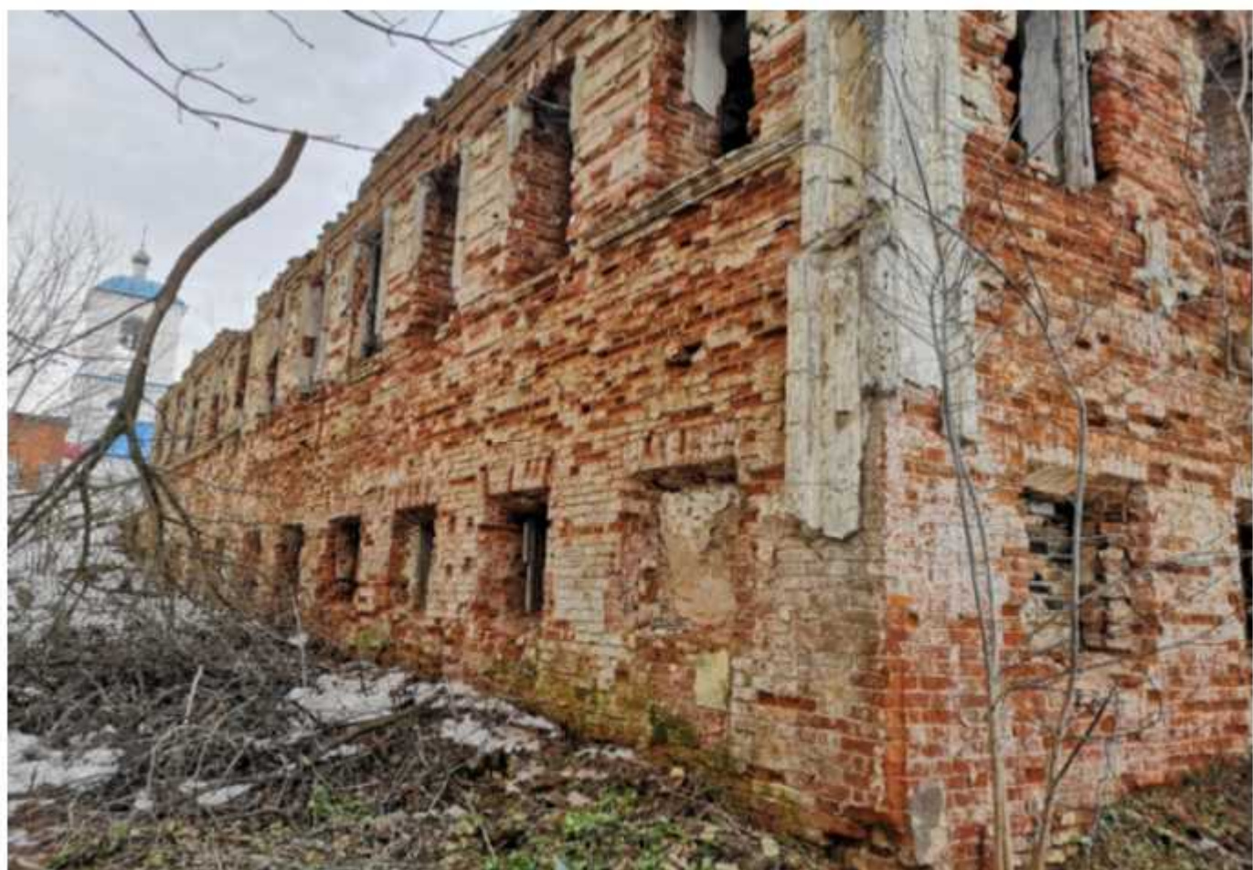
Фото 8. Фасад западной пристройки.
