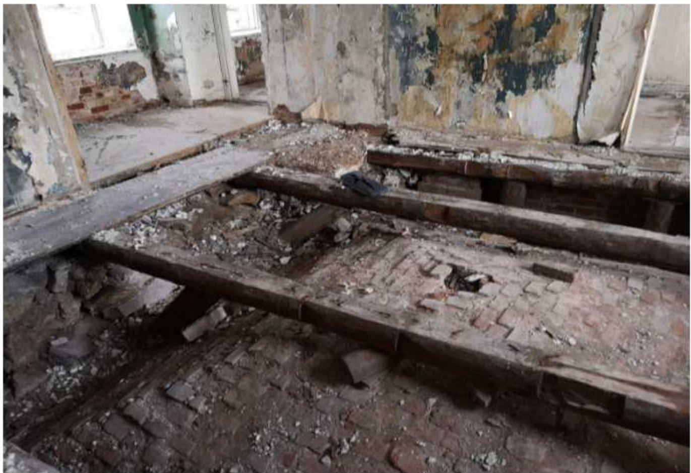
Фото 18. Балки пола 1-го этажа над кирпичным сводом цоколя в осях 5-6/А-В.
