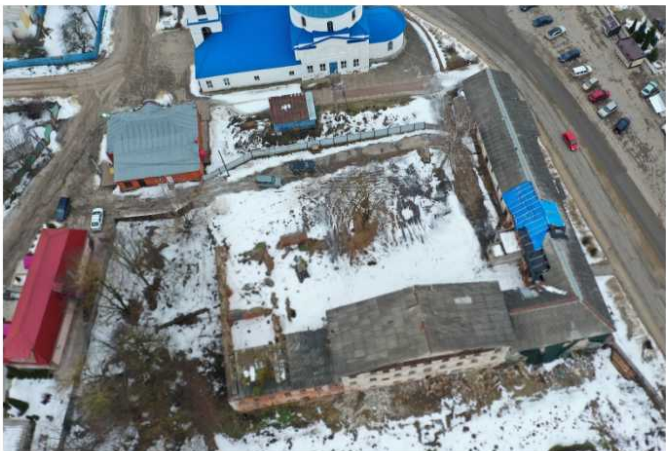
Фото 2. Общий вид объекта и прилегающей территории.
