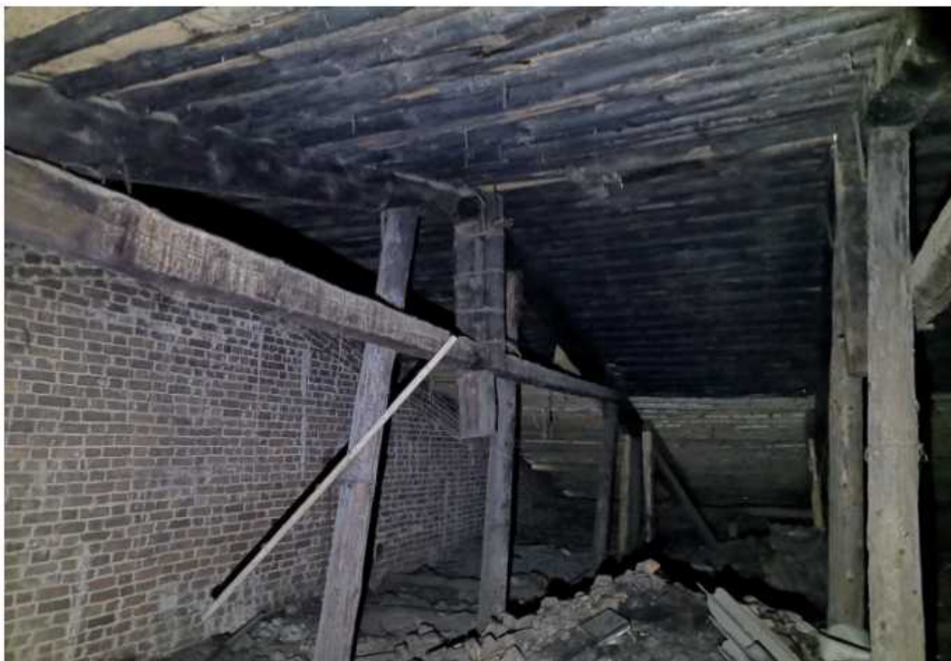
Фото 27. Стропильная система кровли основного здания.
