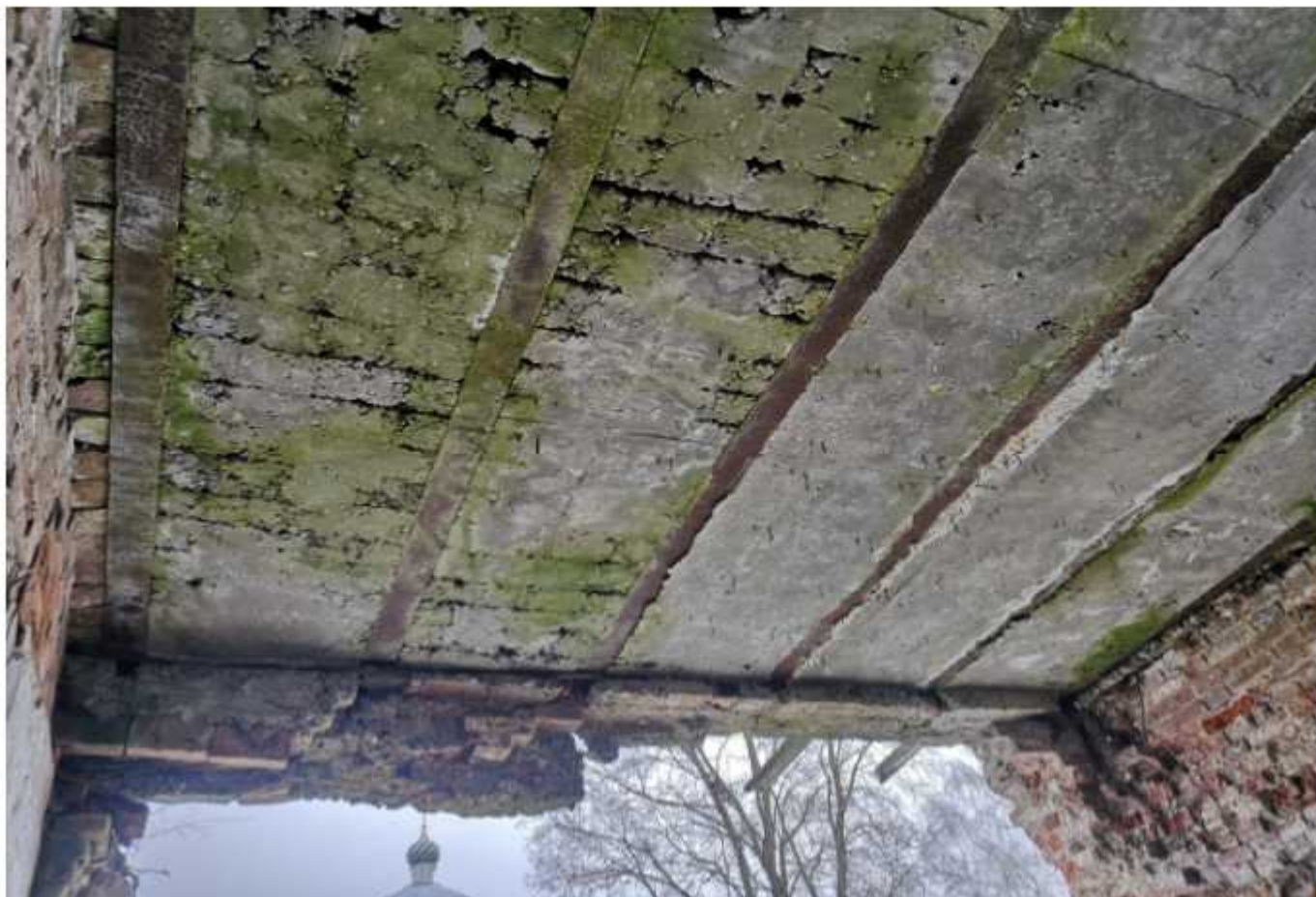
Фото 11. Перекрытие западной пристройки в осях 1-4/А-Б.
