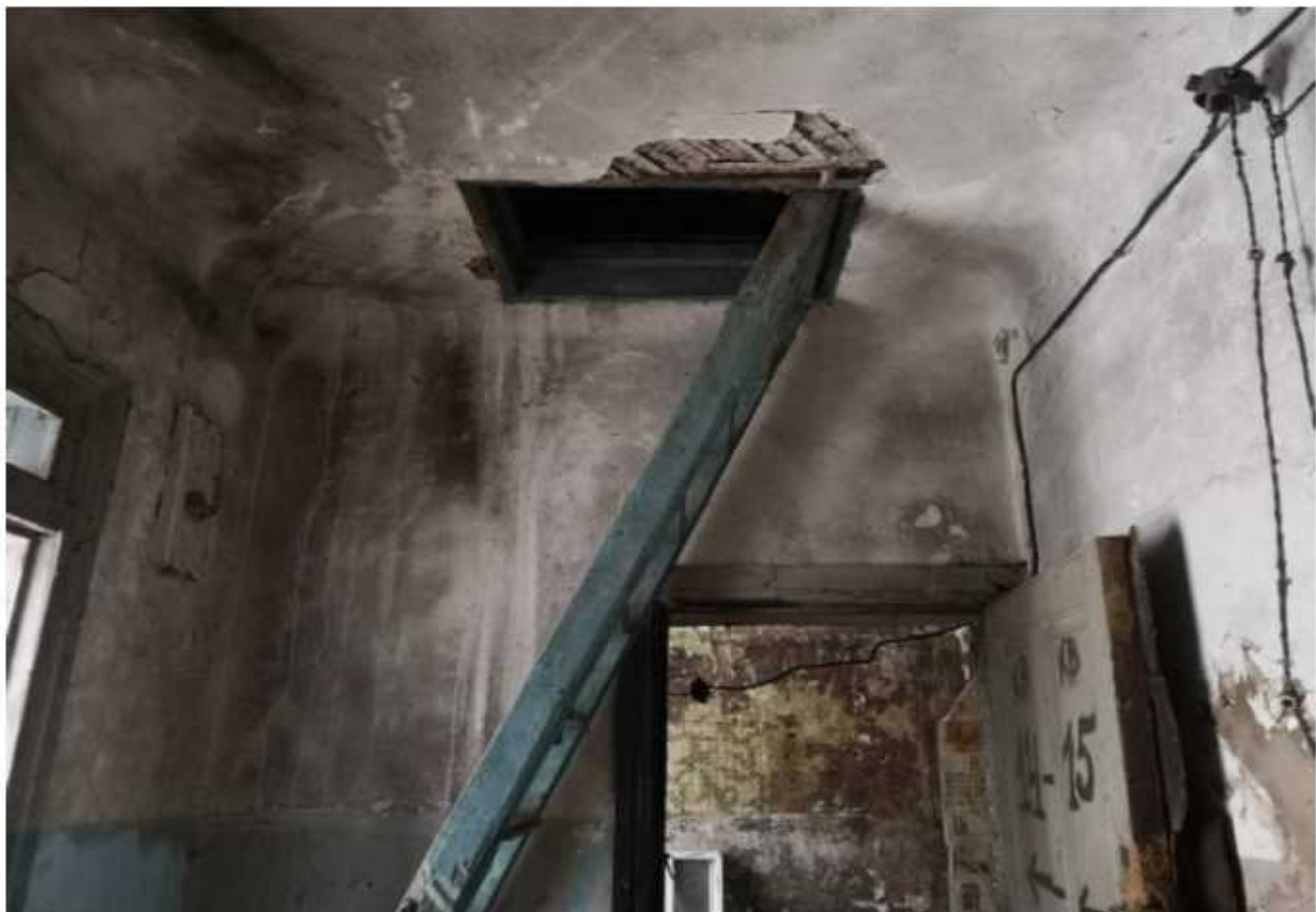
Фото 19. Лестница в чердачное помещение основного здания.
