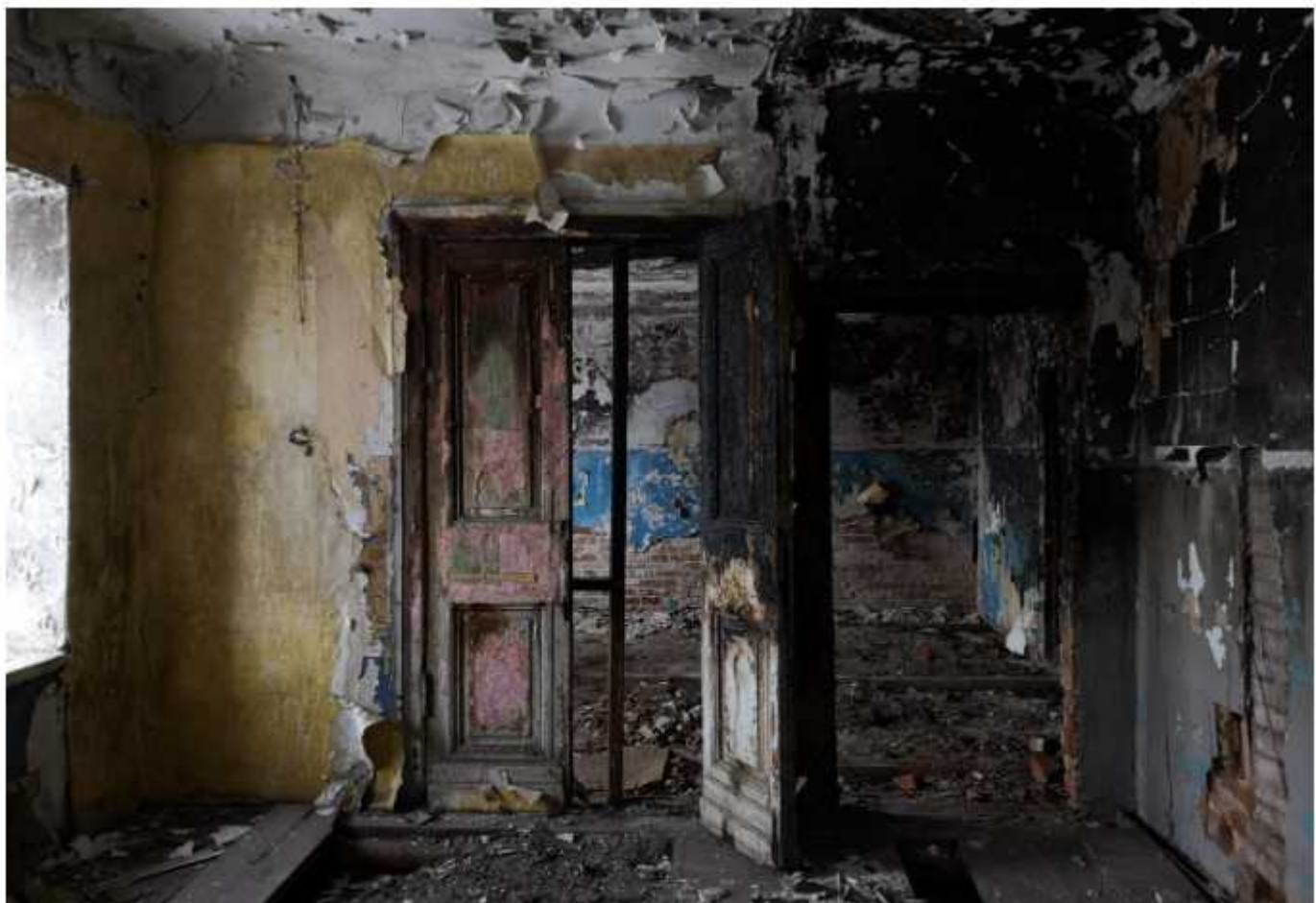
Фото 15. Помещение 2-го этажа основного здания в осях 4-5/А-В.
