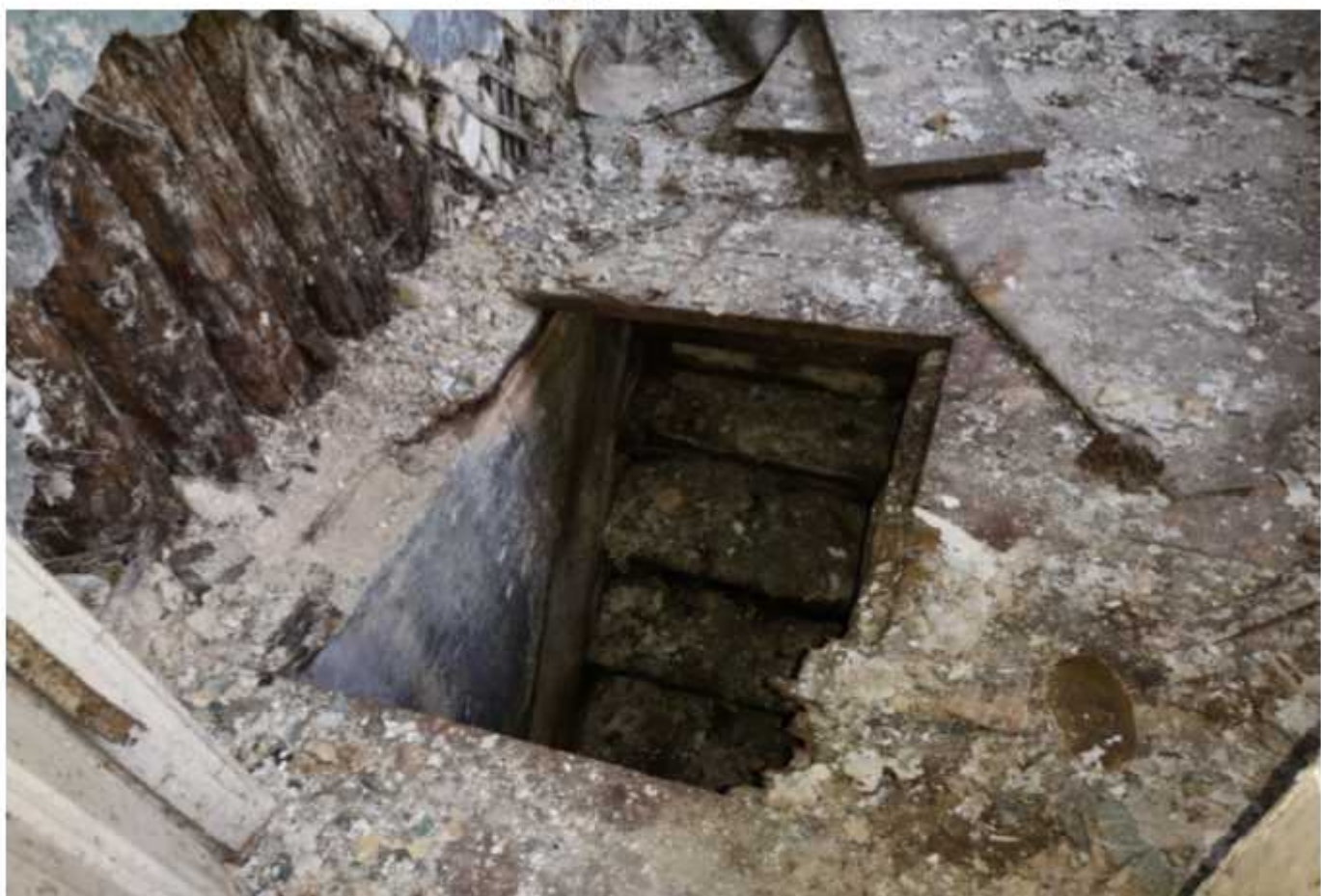
Фото 20. Спуск в подвал в осях 9/И-Л (деревянная лестница).
