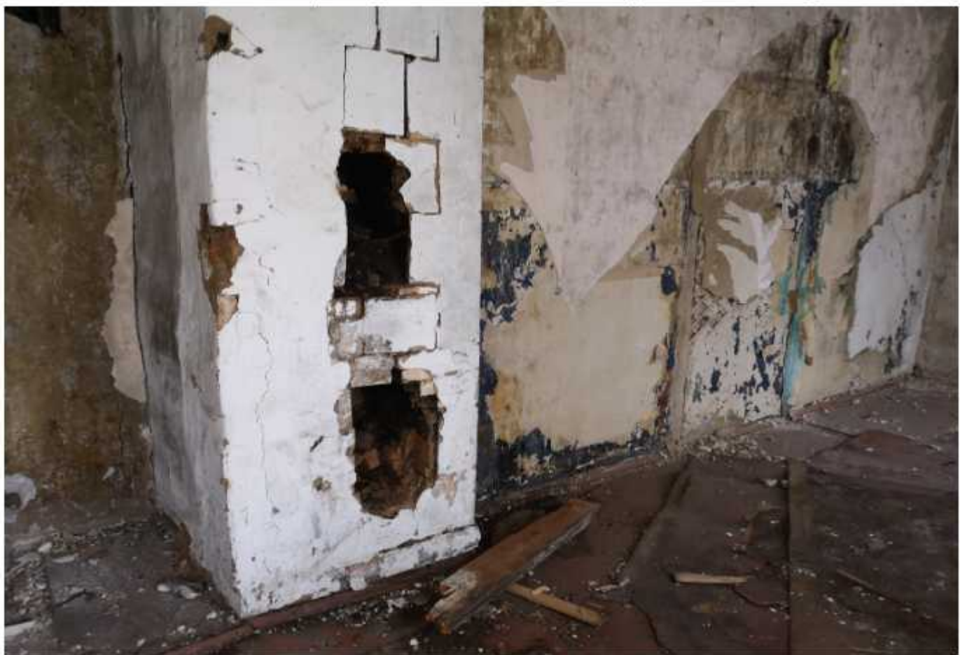
Фото 16. Разрушенные печи.
