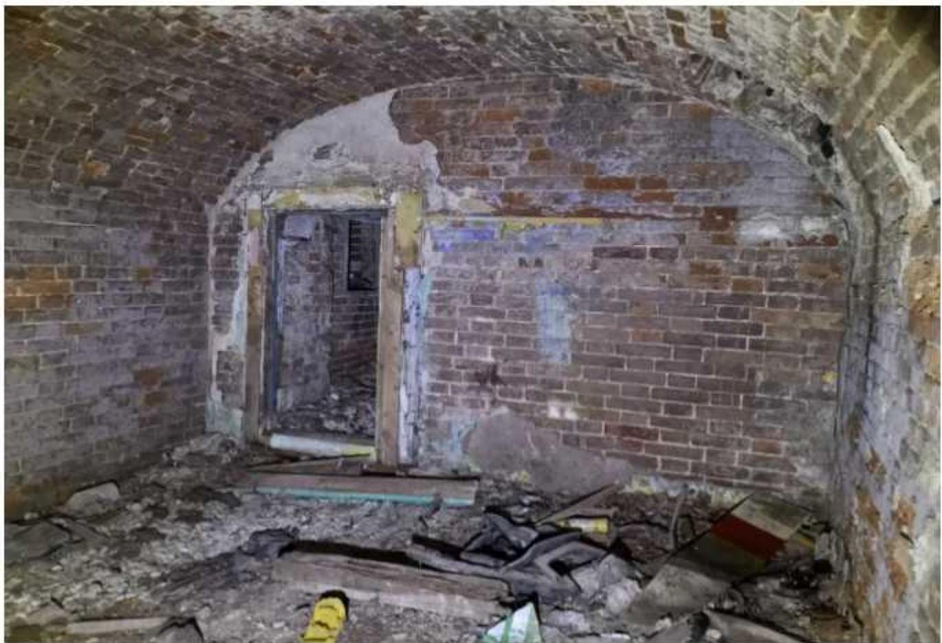
Фото 13. Помещение цокольного этажа западной пристройки в осях 1-2/Д-Ж.
