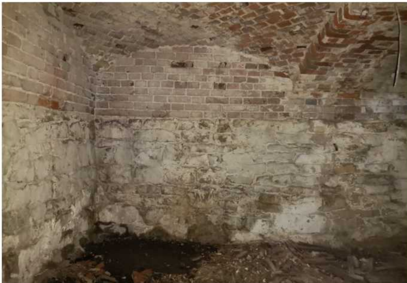
Фото 25. Подвал в осях 9-10/А-Г. Общий вид.
