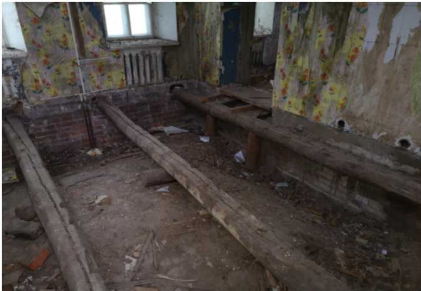
Фото 23. Балки пола 1-го этажа помещения в осях 9-10/Г-Е.
