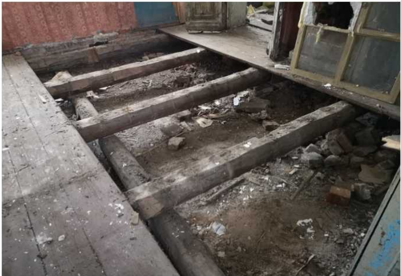
Фото 17. Балки пола 2-го этажа в осях 6-7/А-В.
