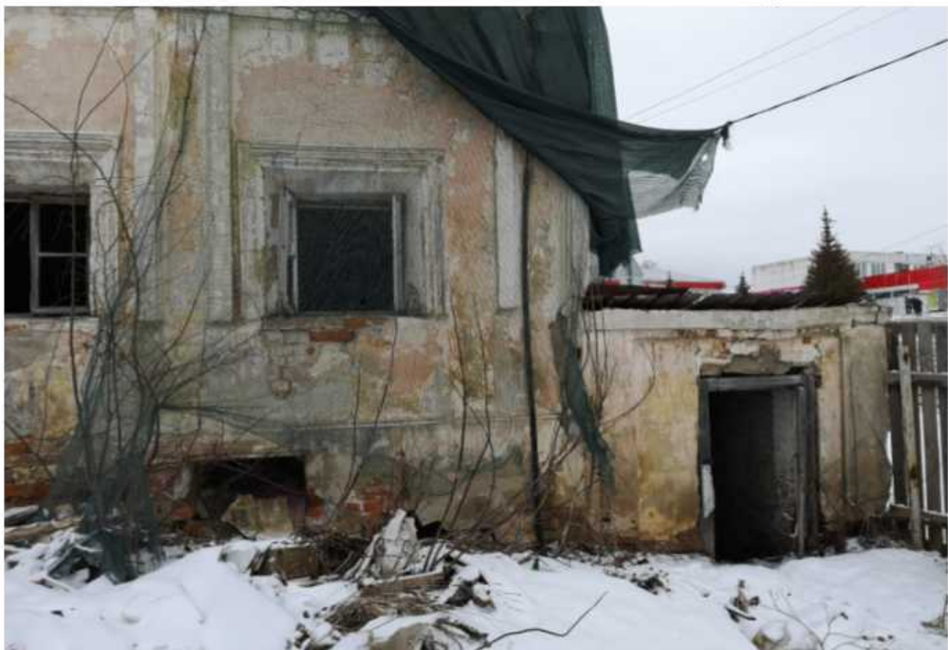
Фото 24. Вход в подвал в осях 10/А.
